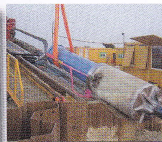
Aplicación „HDD-Assit“ Soltar varillas de perforación atascados
