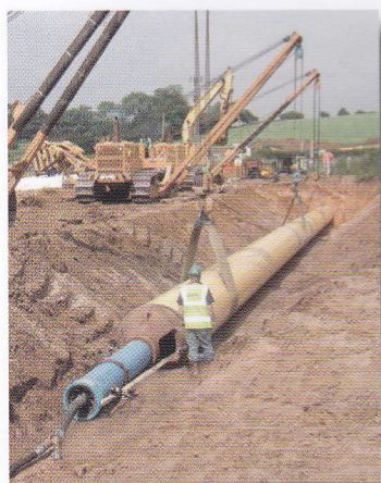
... en la instalación de una Pipeline
