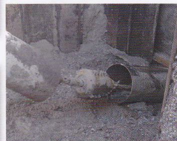
Aplicación „HDD-Assit“ Perforación en una tubería casing
