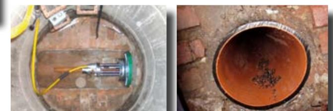
Óptima conexión de las tuberías cortas con BURSTFIX.
