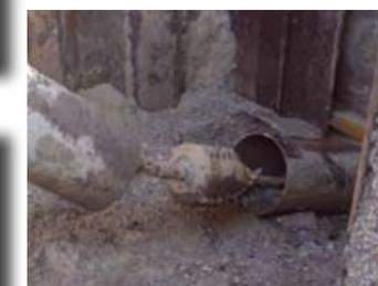
Aplicación „HDD-Assist“ Perforación en una tubería casing
