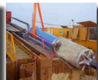
Aplicación „HDD-Assist“ Soltar varillas de perforación atascadas
